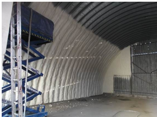
Příklad aplikace v provozní hale/Example of application in shop floor
