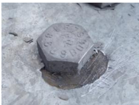
Problémy s přilnavostí žárového povlaku/ Adhesion problems of galvanized coating
