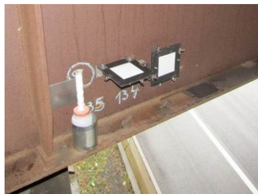
Měřené depozice chloridů na mostní konstrukci/ Chloride deposition measurement on bridge structure
