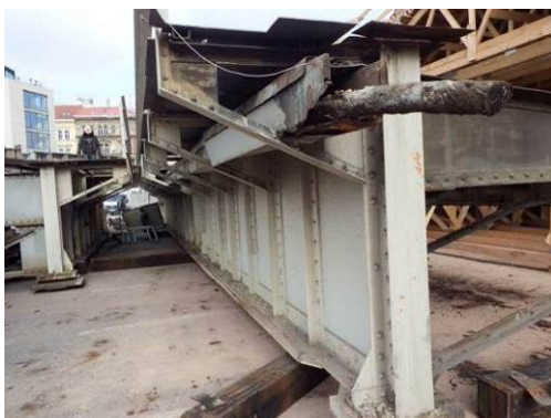
Demontovaná mostní konstrukce/Dissembled bridge structure
