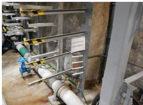
Instalace kupónů v kolektoru Praha/Coupons' installation in Prague collectors
