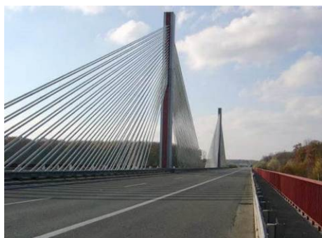
Sledovaný most na dálnici D11/Measured bridge on highway D11
